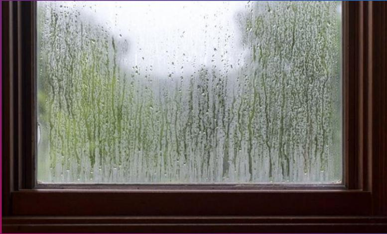
*L'umidità da condensa si forma per il cambiamento di stato del vapore acqueo, che dirigendosi verso le parti più fredde, condensa, passando dallo stato gassoso a quello liquido.*
